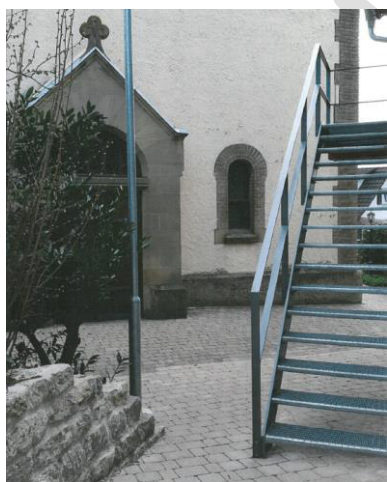
Abb. 1: Engstelle zwischen Fluchttreppe und Mauer; Quelle: Gde. Roigheim
