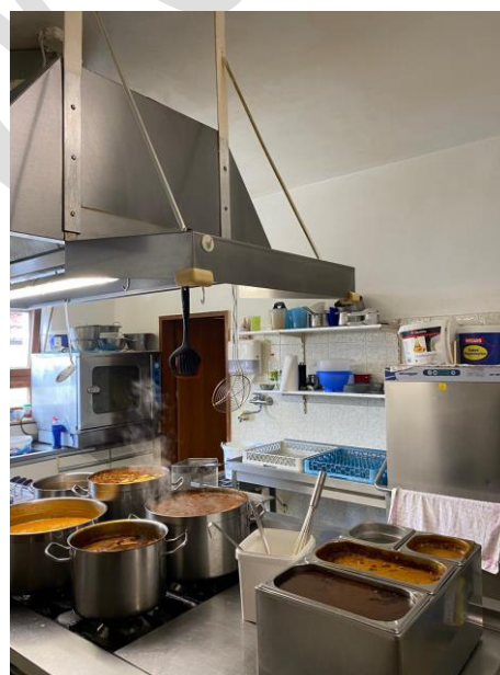
Abb. 2: Aktuelle Situation; Ort für Multibräter Quelle: Projektträger
